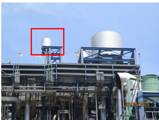
ภาพที่ 2.2-8 การติดตั้ง Silencer
