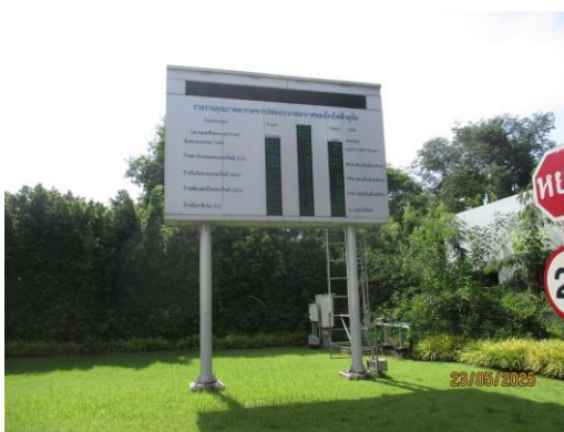
ภาพที่ 2.2-3 จอแสดงผลการตรวจวัดคุณภาพอากาศจากปล่องระบายบริเวณหน้าโครงการ
