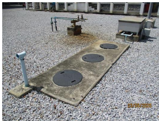
ภาพที่ 2.2-15 ถังบำบัดน้ำเสียจากการอุปโภค-บริโภค
