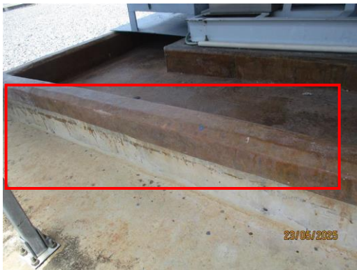
ภาพที่ 2-32 พื้นที่เก็บสารเคมีที่มีคันคอนกรีตรัดล้อมรอบถึงเก็บสารเคมี
