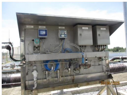
ภาพที่ 2.2-11 เครื่องตรวจวัดคุณภาพน้ำหล่อเย็น แบบอัตโนมัติบริเวณบ่อพักน้ำหล่อเย็น
