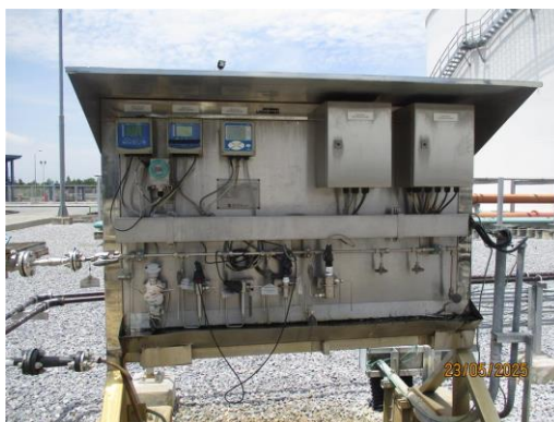
ภาพที่ 2.2-19 เครื่องตรวจวัดคุณภาพน้ำแบบอัตโนมัติ บริเวณบ่อพักน้ำทิ้ง
