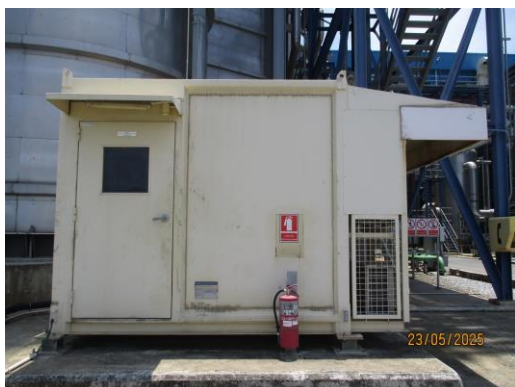
ภาพที่ 2.2-2 ระบบตรวจวัดคุณภาพอากาศจากปล่องระบายอากาศอย่างต่อเนื่อง (CEMs)
