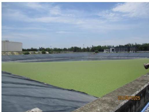
ภาพที่ 2.2-10 บ่อพักน้ำหล่อเย็น ขนาด 11,000 ลูกบาศก์เมตร
