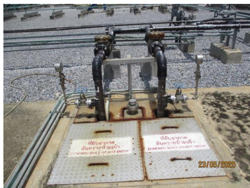
ภาพที่ 2.2-13 วาล์วควบคุมการเปิด-ปิด บริเวณบ่อตรวจสอบคุณภาพน้ำทิ้ง
