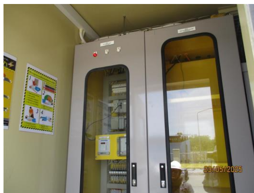
ภาพที่ 2.2-2 ระบบตรวจวัดคุณภาพอากาศจากปล่องระบายอากาศอย่างต่อเนื่อง (CEMs)
