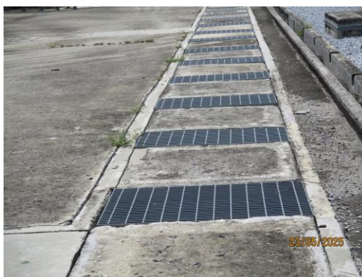
ภาพที่ 2.2-16 รางรวบรวมน้ำที่อาจปนเปื้อนน้ำมัน
