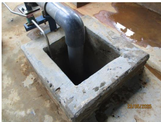
ภาพที่ 2.2-14 ถังปรับสภาพความเป็นกรด -ด่าง (Neutralization Tank)
